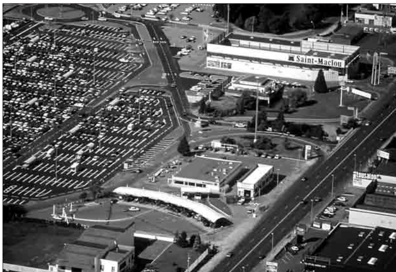
Vue aérienne de grande surface et de parking associé, Orléans.
