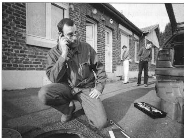
Relais avec le service de l'eau.
