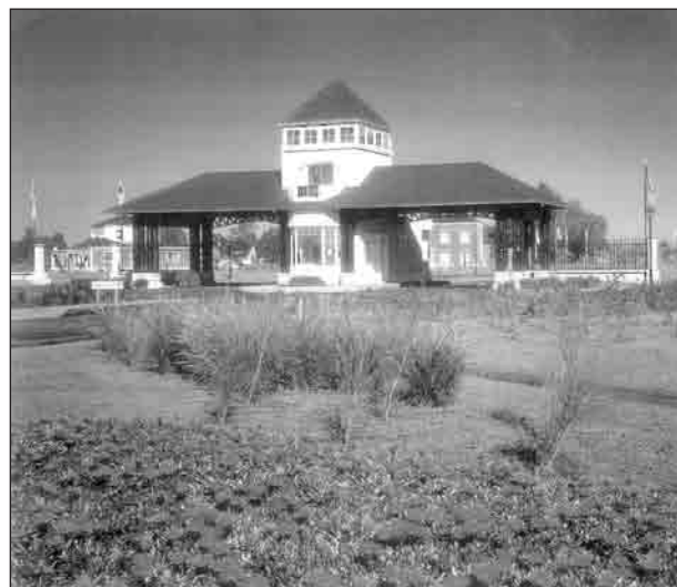
Le poste de contrôle d'un sous-quartier de Pilar del Este.
