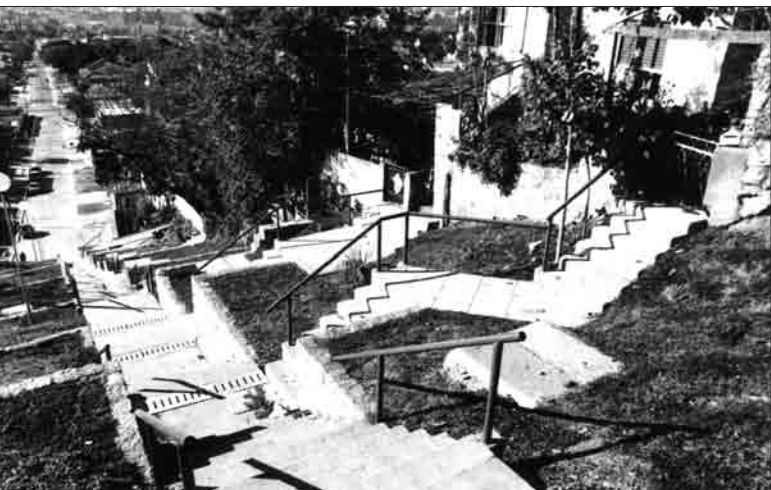
Les escaliers drainants des quartiers réguliers
