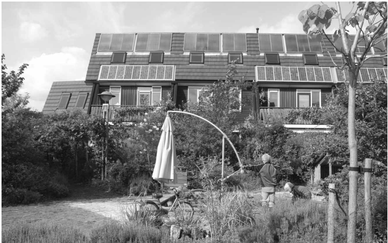
Cour végétalisée à Eva-Lanxmeer et panneaux solaires, Pays-Bas
