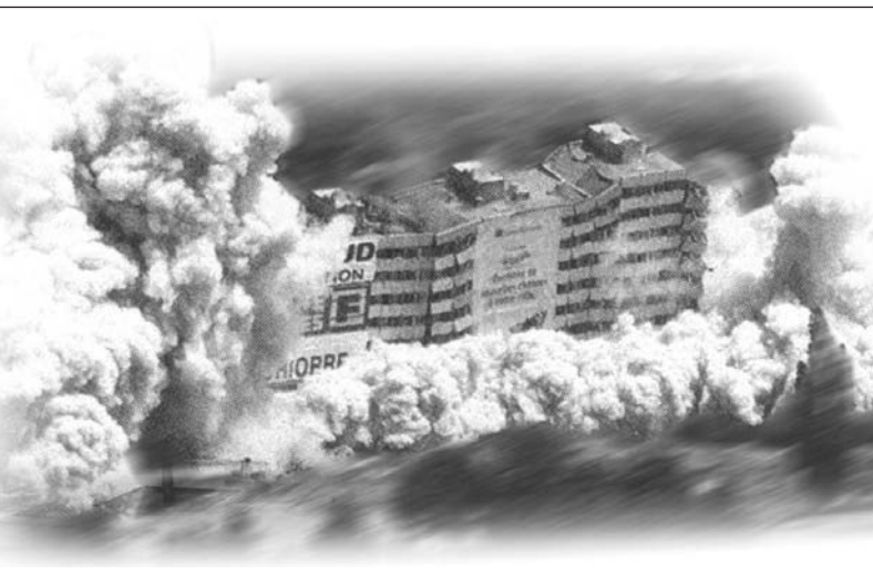
Démolition de la « muraille de Chine », quartier Montchovet, Saint-Étienne.
