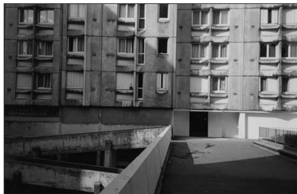
Un arbre à la place de la passerelle changerait l'ambiance.
