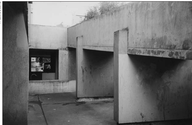
Passerelle à supprimer, au pied des immeubles des Hauts de Belleville.
