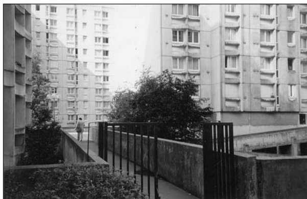
La suppression de cette passerelle permettrait de réhabiliter un habitat en pied d'immeuble.
