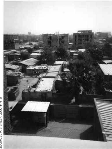
Figure 4. Vues de Zangouettin, vieux quartier central détruit pour le projet Zaca
