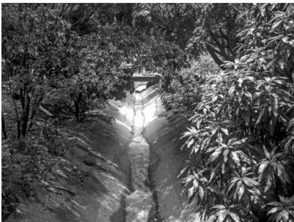
Canalisation près du quartier San Bernardo, comuna 16 (photographie prise par une participante).
