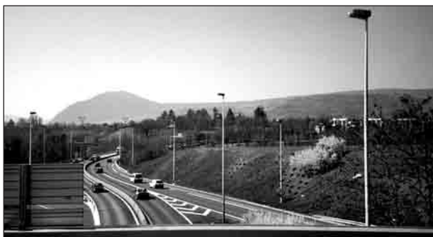
Anney : entrée de la voie rapide pénétrant dans la commune centre.
