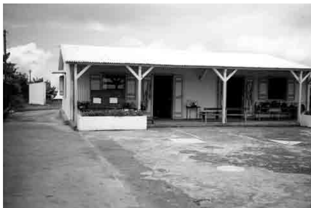
École en bois sous tôle.
