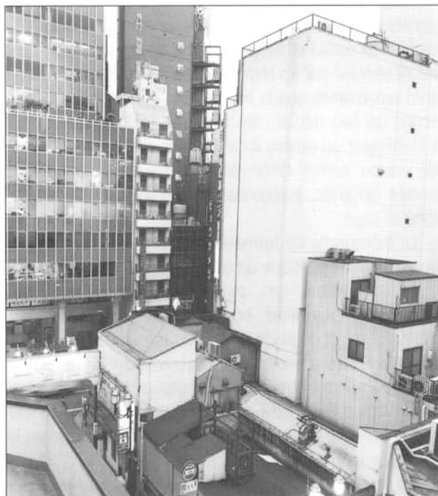
Tokyo, construction en surélévation © Bernard Descamps/VU
