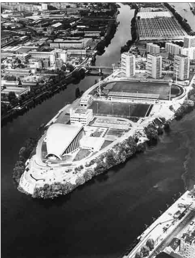
Terrains sur l'Île Saint-Denis.
