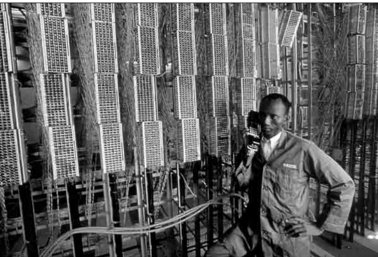
Infrastructures centralisées, téléphonie Onatel, Burkina Faso.
