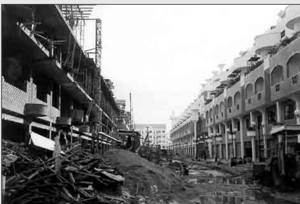
Construction d'un quartier résidentiel (Hô Chi Minh-Ville, août 1996).
