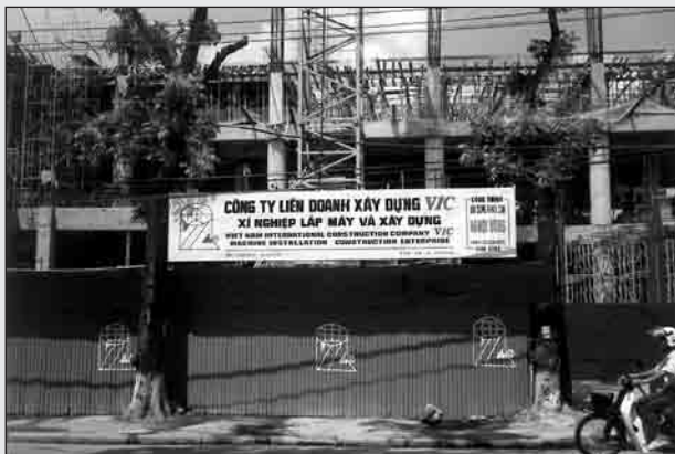
Le chantier interrompu du Golden Hôtel.
