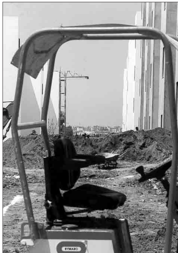
Chantier de Sala Jâida, ville nouvelle construite par une filiale de Bouygues.
