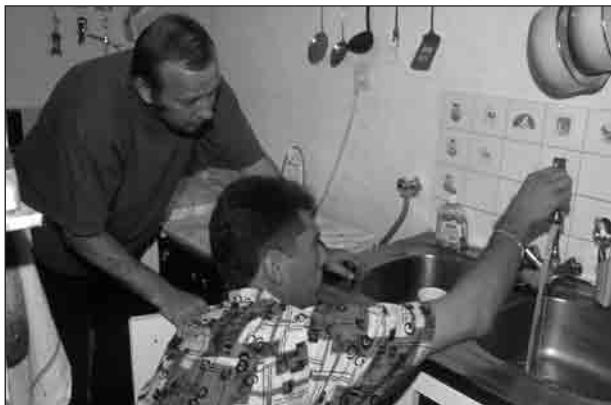
Réparations locatives par une régie municipale.
