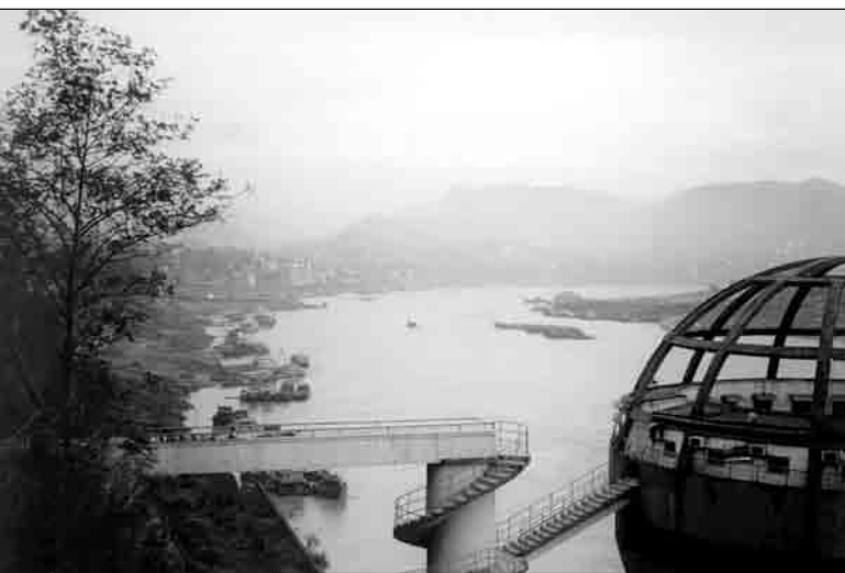
Depuis la station d'eau potable n° 3.
