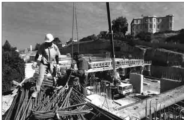
Chantier de la Rocade L2 et bastide
