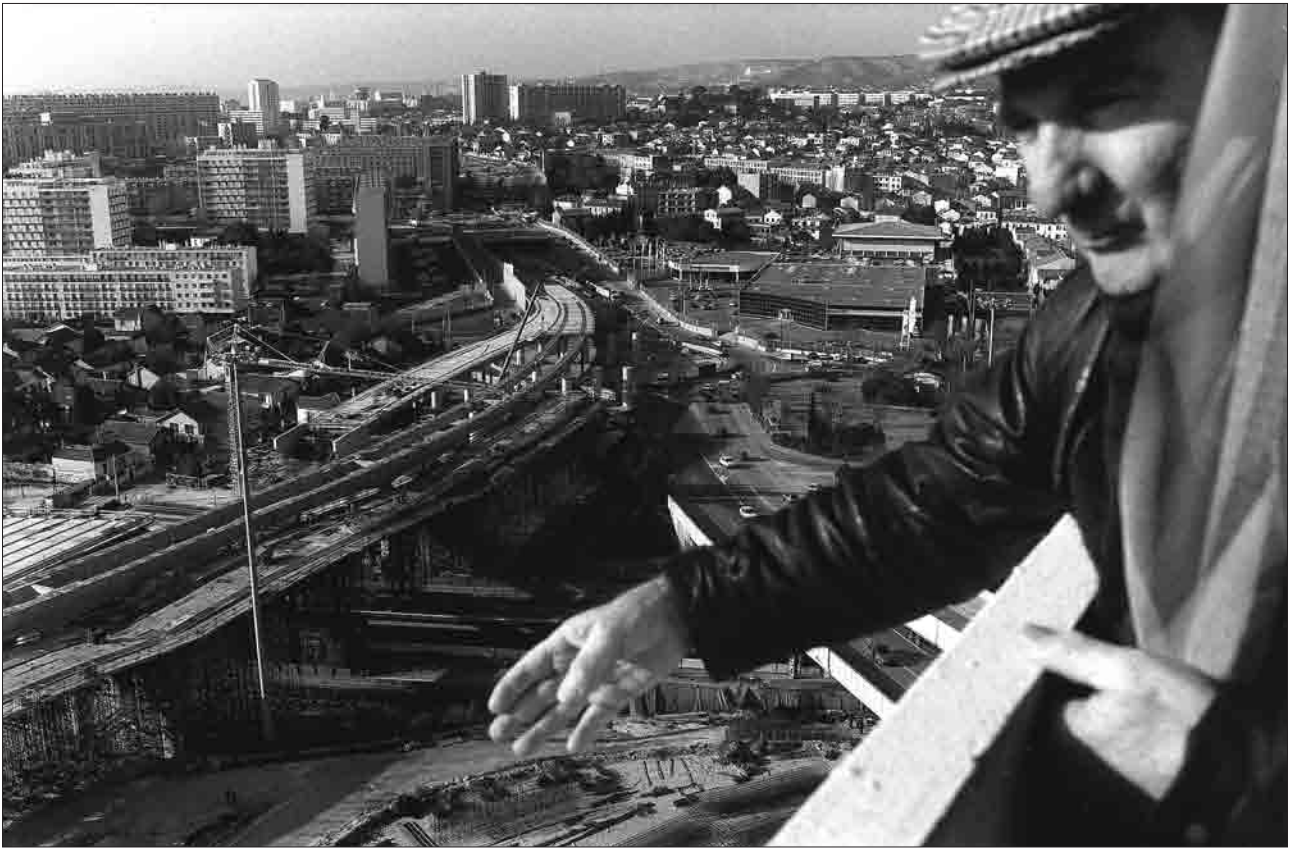
Chantier de la Rocade L2 et cités
