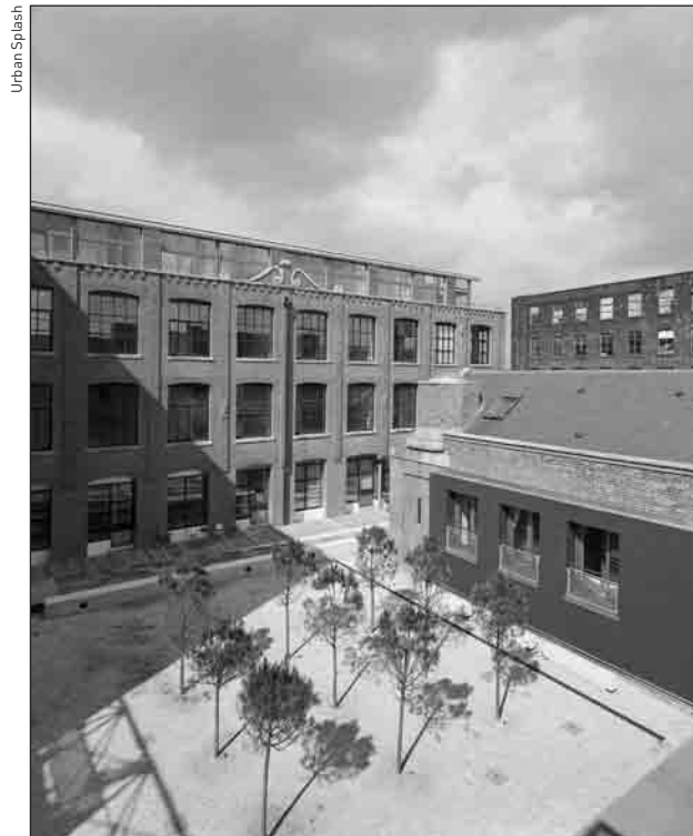
Britannia Mills Castlefield, Manchester, rénovation en logements.
