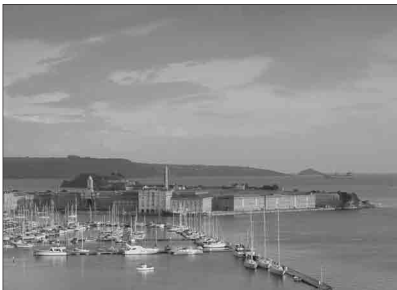
Royal William Yard, Plymouth, rénovation en hôtel.
