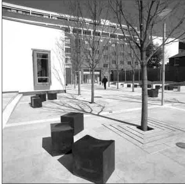
Manufacture des thés, Liverpool, rénovation en logements.
