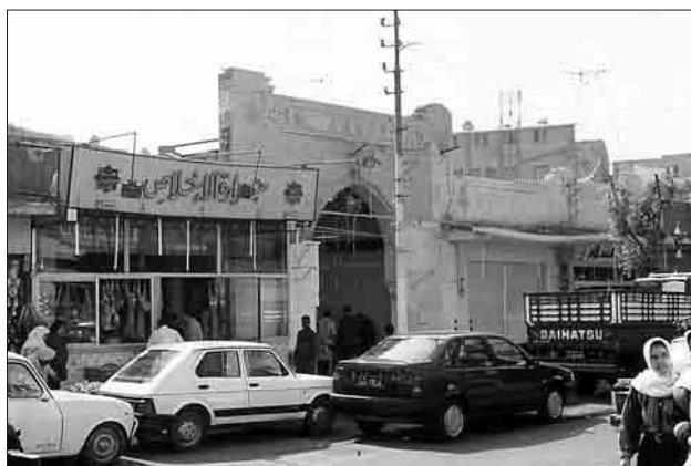
Vue d'une des entrées latérales du marché d'Héliopolis.
