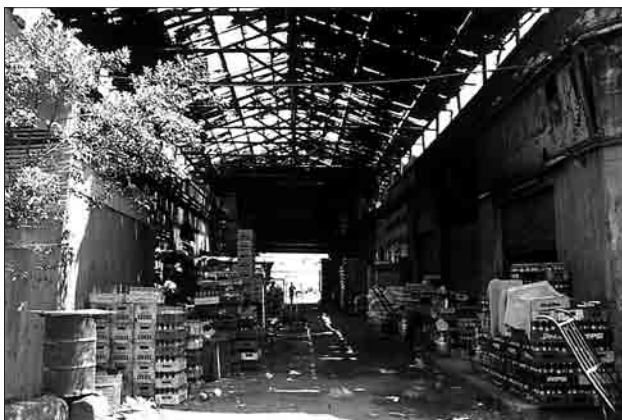
Vue de l'allée principale du marché de la Gare du Caire, dans son état actuel.
