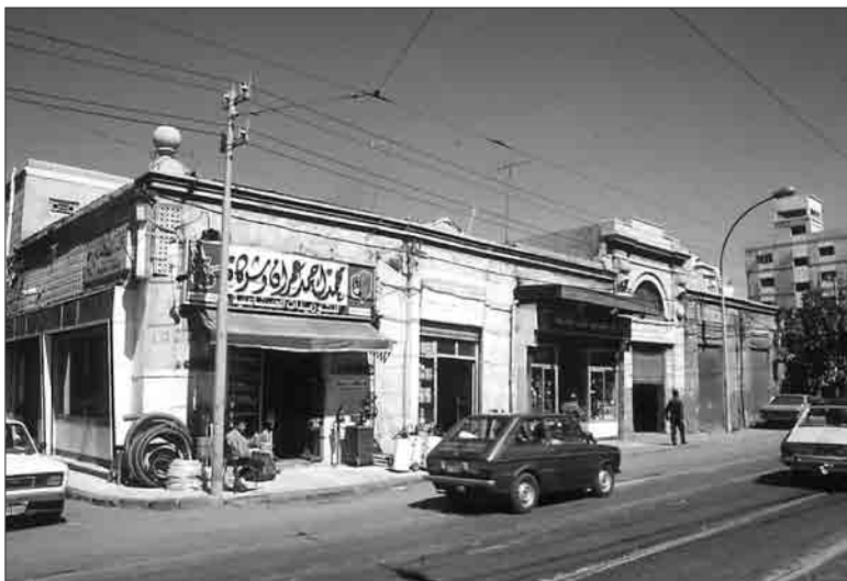
Vue actuelle du Nouveau Marché d'Alexandrie, côté porte principale. Ce marché n'est plus en activité et trois des quatre «halls» n'ont plus de toiture. L'ensemble a été subdivisé en petits ateliers de réparation de voitures, de chaudronnerie et garages.
