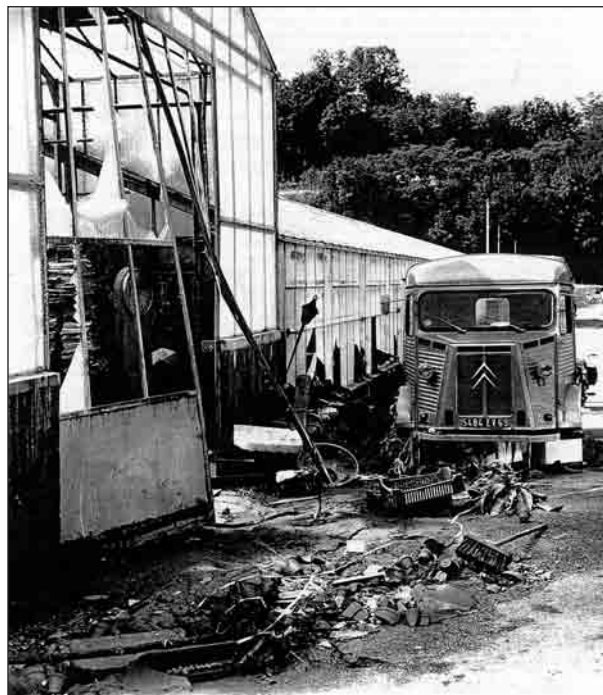
Les serres Morel après la crue du 11 août 1973.
