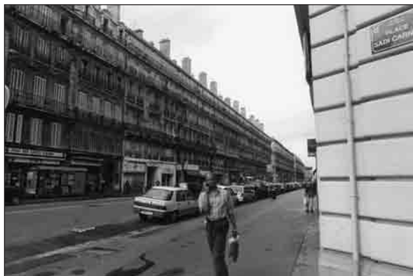
Rue de la République, linéaire de façade.
