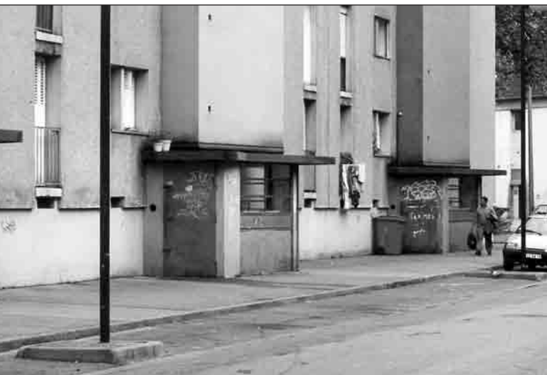
Des détériorations volontaires...
