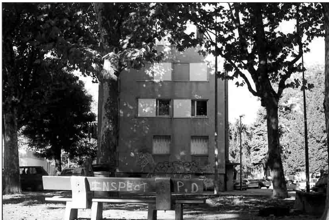
Dégradations dans un quartier « destroy ».
