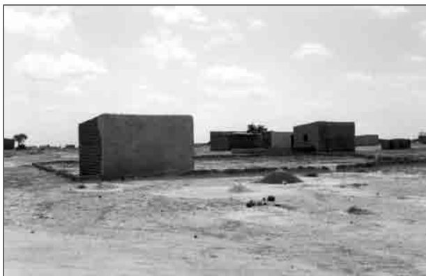
Parcelle en non-loti à Taptenga. Certaines maisons ne sont crépies que d'un seul côté : l'orient. On cherche en effet à limiter au maximum les investissements et on ne protège que la face « au vent » qui est la plus vulnérable.
