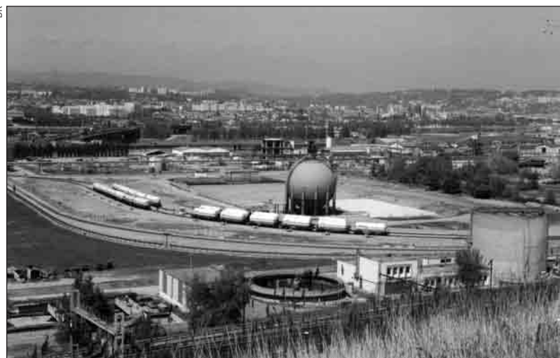
DR Le risque, catastrophe virtuelle : la sphère de stockage de chlorure de vinyle monomère ou CVM, produit hautement inflammable et toxique, aujourd'hui sur le site d'Atofina (Saint-Fons).
