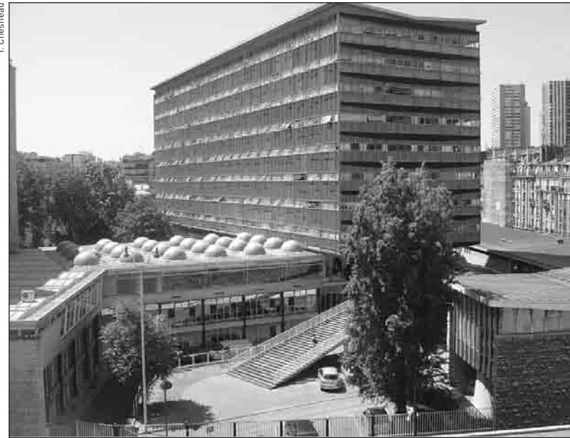
Caisse d'allocations familiales. Raymond Lopez, architecte, 1959. Rue Viallat, Paris, 15 e .
