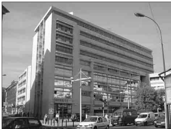
Immeuble Atlas, Montreuil.
