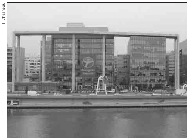
Arcs de Seine : restructuration de l'ancien siège Renault à Boulogne.
