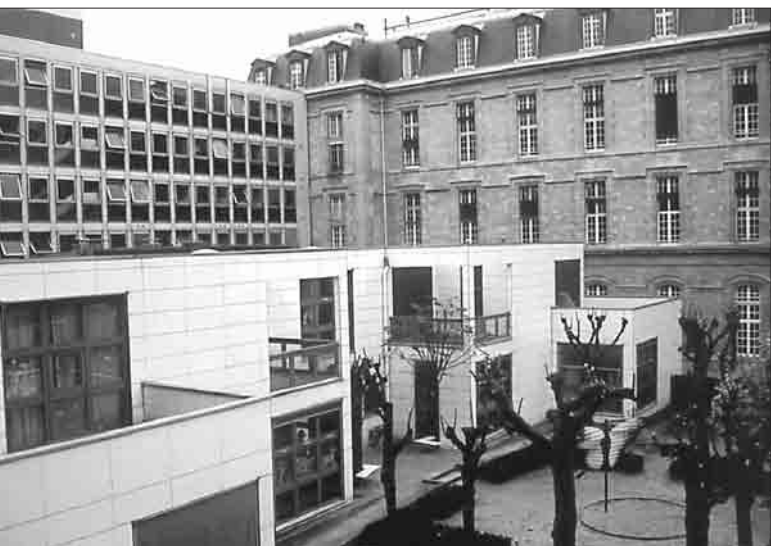
Hôpital Tenon, dans une cour latérale : le bâtiment d'origine, une barre de services médicaux substituée à une galerie au cours des années 1970 et une crèche, due à Vardi, greffée au cours des années 1980 sur le bâtiment précédent.
