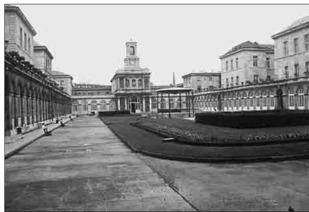
Hôpital Lariboisière. En haut : travaux sur les réseaux souterrains. En bas : la cour centrale, dont l'aspect a été préservé. On devine les pavillons, disposés en redans le long des galeries de liaison.
