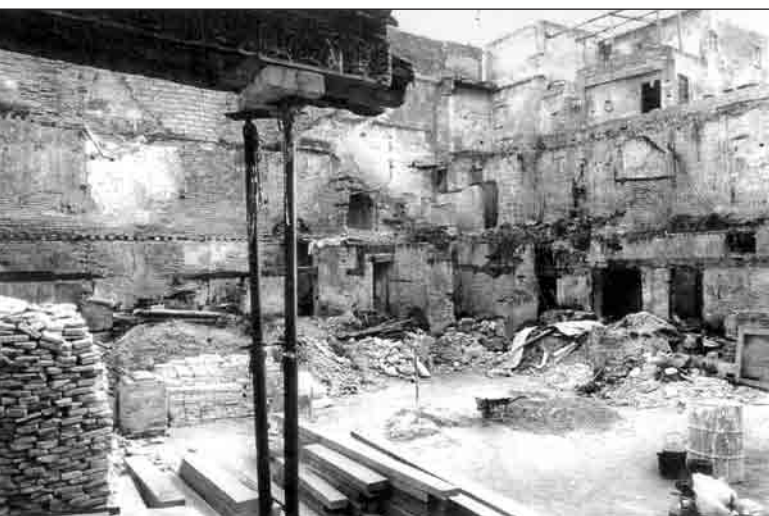
Rénovation du parc existant, 1993.
