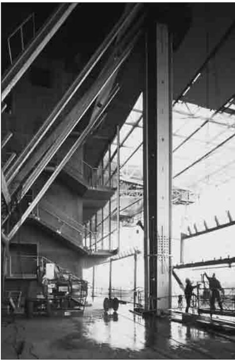
Le Stade de France en chantier: montage de la résille.
