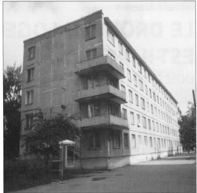
Immeuble "krouchtévien" Saint Pétersbourg - © I.A.-
