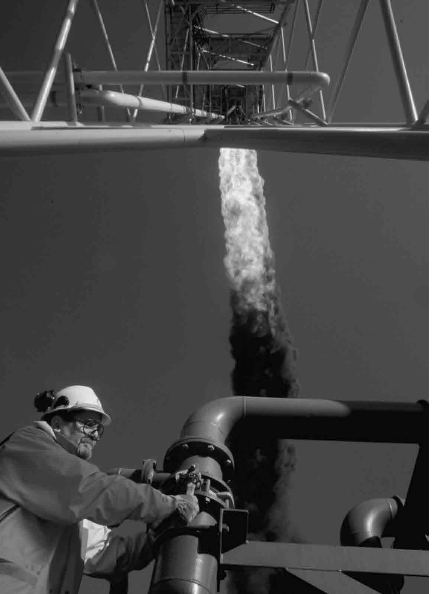
Plateforme pétrolière offshore en mer du Nord. Benoît Decout/REA
