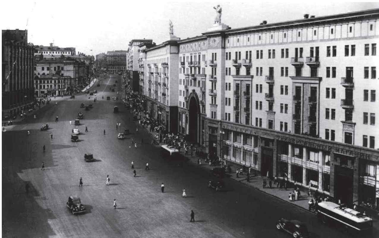
Rue Gorki en cours de reconstruction.
