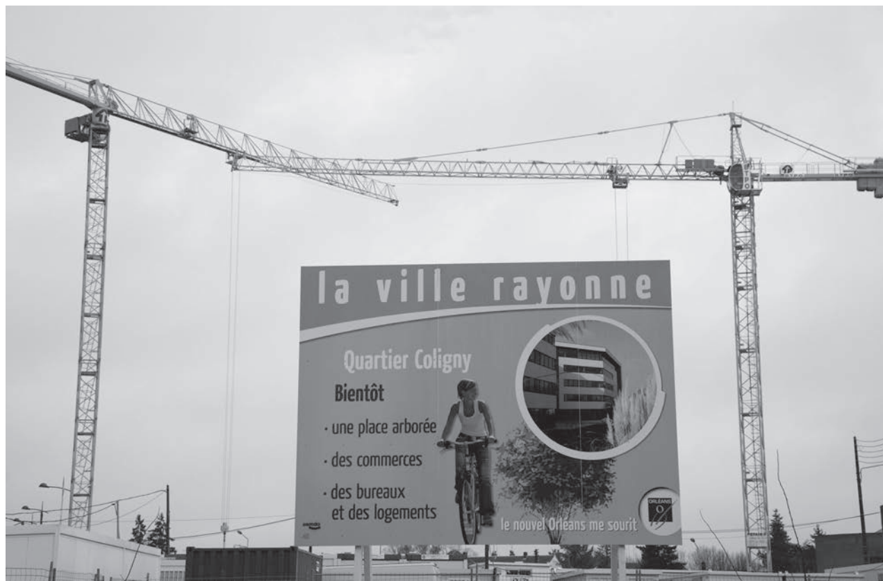
Le quartier de la Râpe et ses nouvelles constructions, à Orléans.
