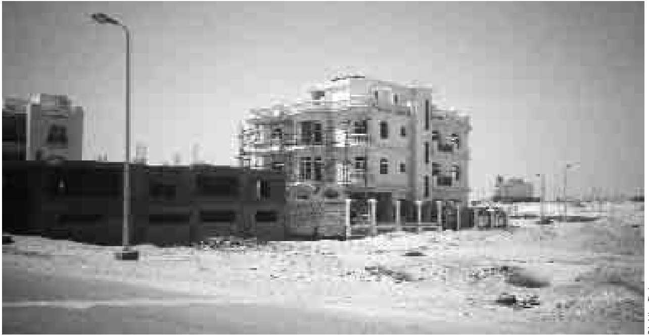
Une villa en construction au Nouveau Caire
