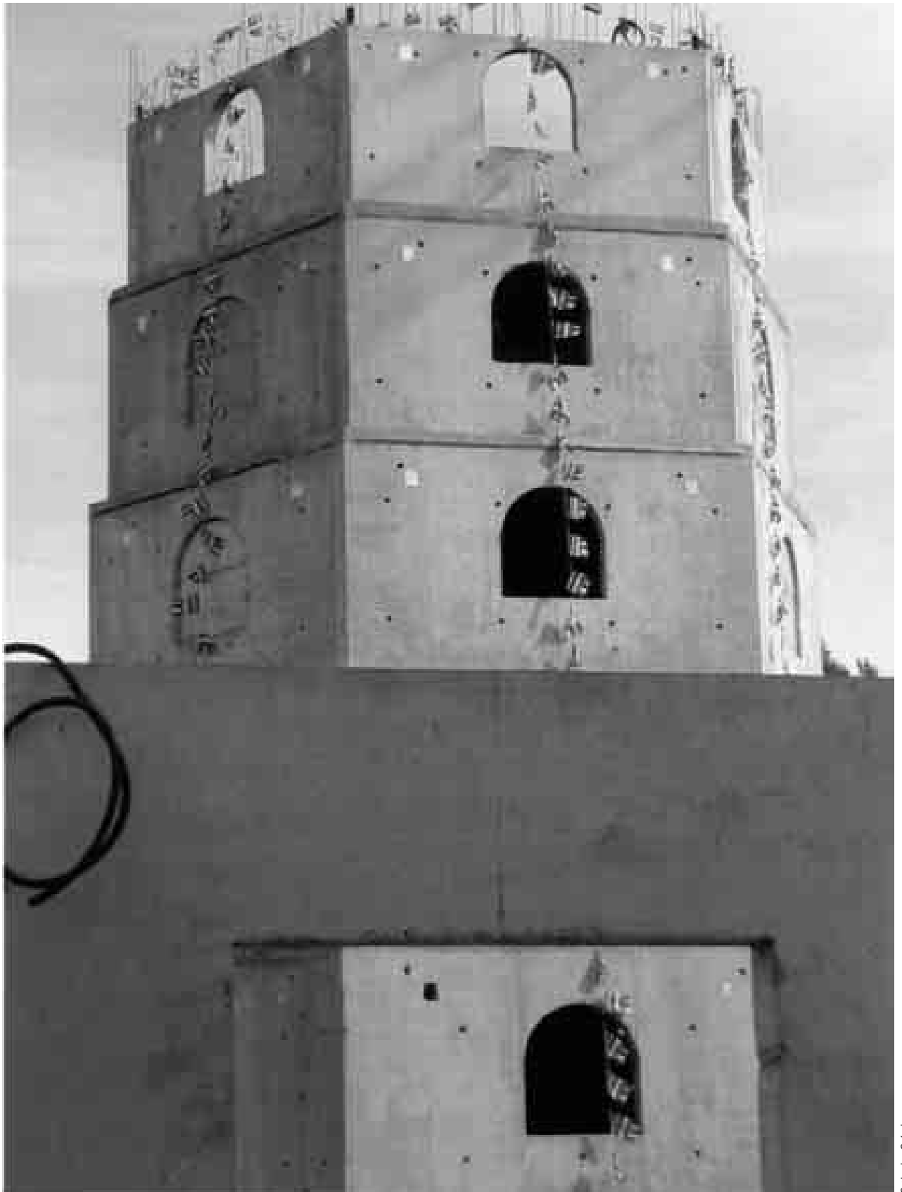
Pagode en construction à Évry
